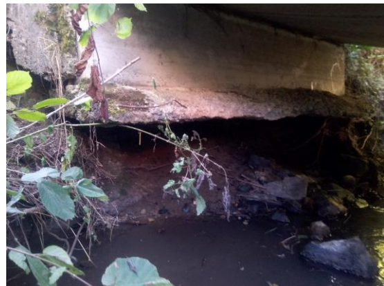
Abbildung 6: Stark unterspülte Widerlager von Strassenbrücken im Mitteldorf
